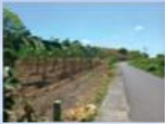
Lokasi berada di tepi jalan yang sudah beraspal
